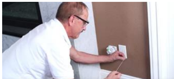
1 Размотать волоконно-оптический кабель InvisiLight® в соответствии с требуемой длиной.
