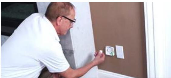
1 Смонтируйте настенный модуль.
