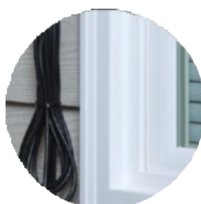
ОБВЯЗКА КАБЕЛЬНЫМИ СТЯЖКАМИ
